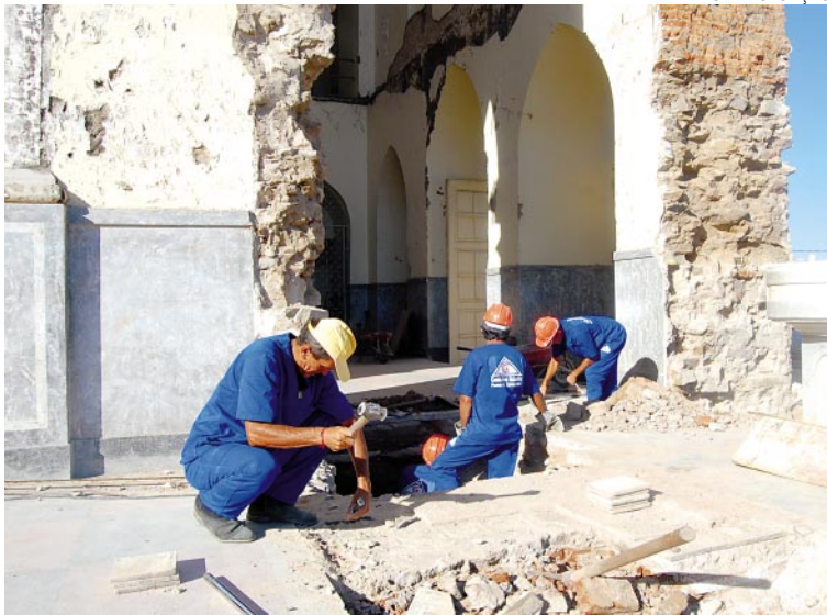
Igreja de Nossa Senhora dos Remédios, em Sousa, está sendo reconstruída
