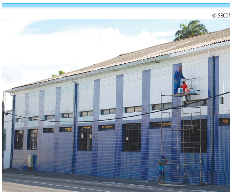
Prédio sede da Casa da Cidadania de Jaguaribe passa por reformas
