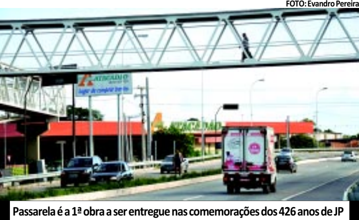
Passarela é a 1ª obra a ser entregue nas comemorações dos 426 anos de JP
