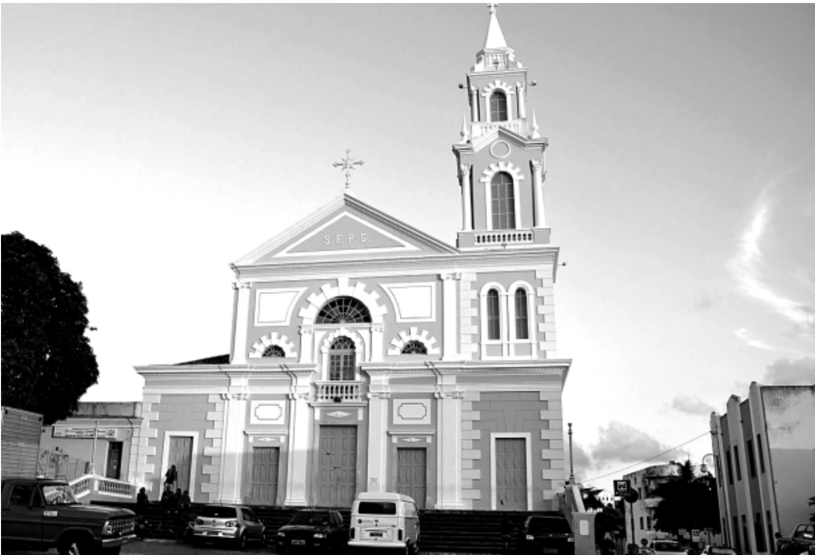
A Igreja de São Frei Pedro Gonçalves, localizada no Porto do Capim, representa um referencial para João Pessoa e foi revitalizada por profissionais da Oficina Escola
