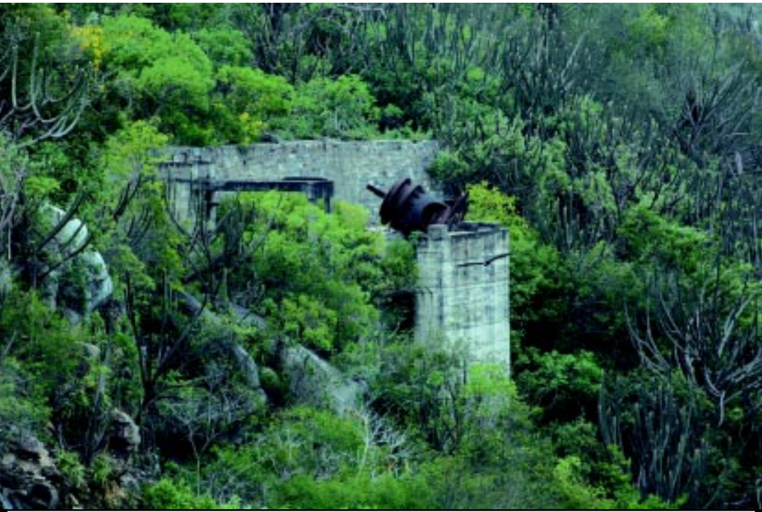
Peças do motor do teleférico estão enferrujadas. A parede de cimento armado permanece lá, semidestruída
