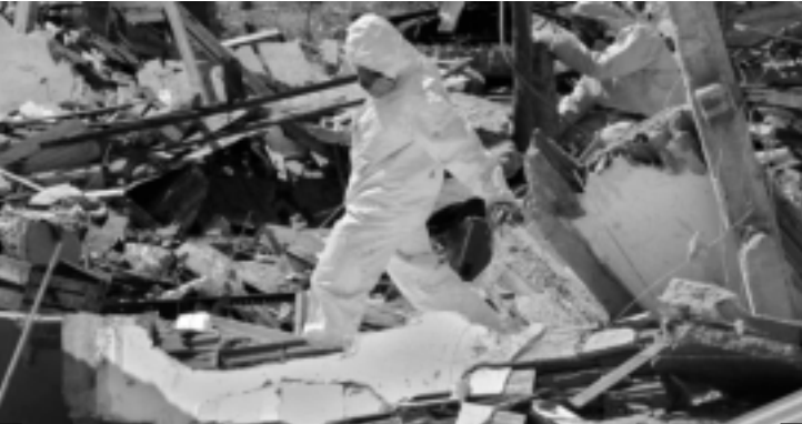
A explosão misteriosa deixou uma casa e três veículos destruídos
