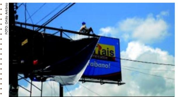
**[FOTO&LEGENDA]** O homem trabalha na manutenção da placa gigantesca e faz uso do capacete. Porém, apesar da altura e do risco com o vento, ele não usa qualquer corda amarrada ao corpo e à estrutura metálica para o caso de uma queda.
