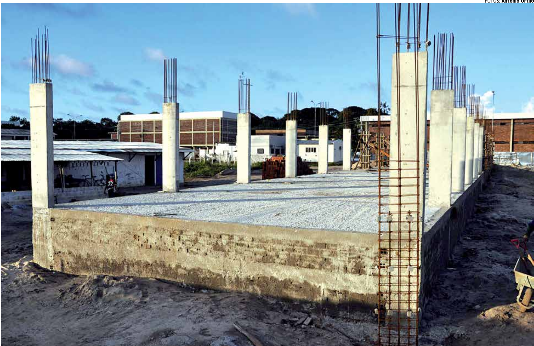
Residencial que está em fase de construção em Campina, que vai abrigar 16 famílias, terá painéis fotovoltaicos para fazer a conversão da energia solar em elétrica
