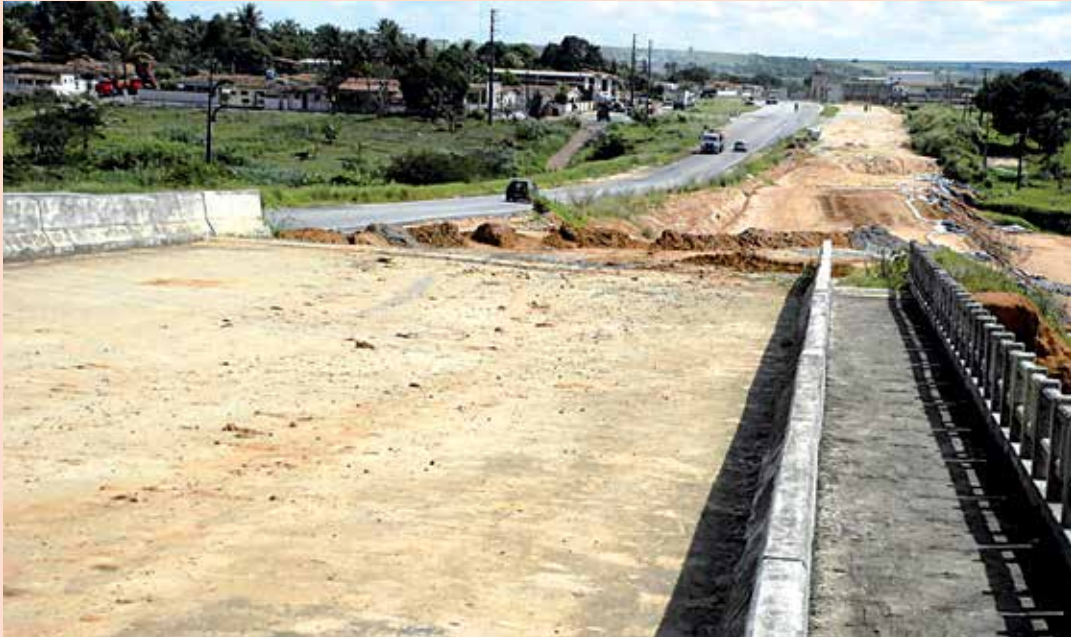
Uma das obras que deverão ser concluídas em breve no Estado é a duplicação da BR-101
