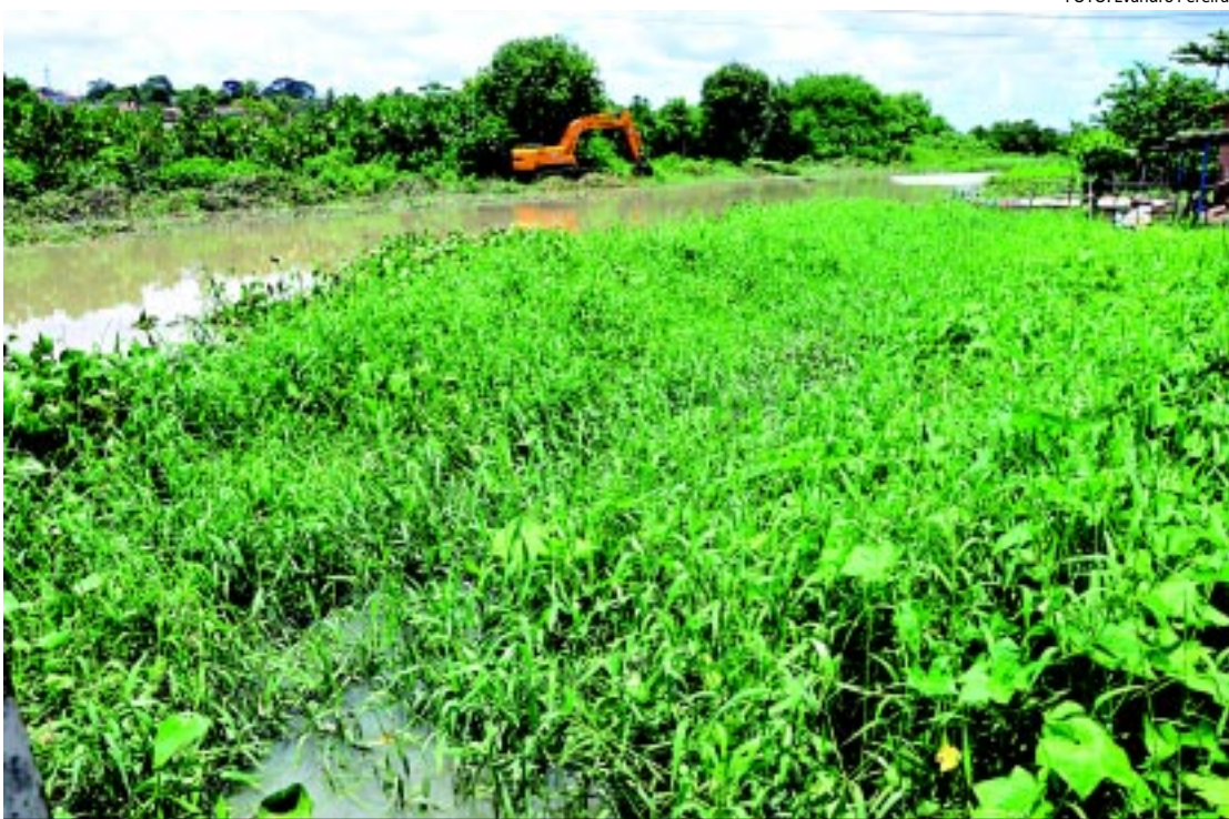
Uma escavadeira hidráulica cedida pela Seinfra realiza o procedimento de limpeza de parte do Rio Jaguaribe
