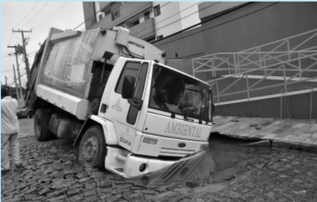
Veículo acabou afundando no local e chegou a estourar uma encanação subterrânea da Cagepa
