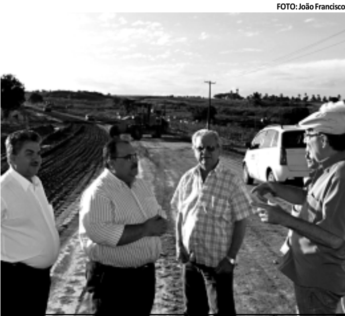
As obras de pavimentação da PB-051 também foram inspecionadas
