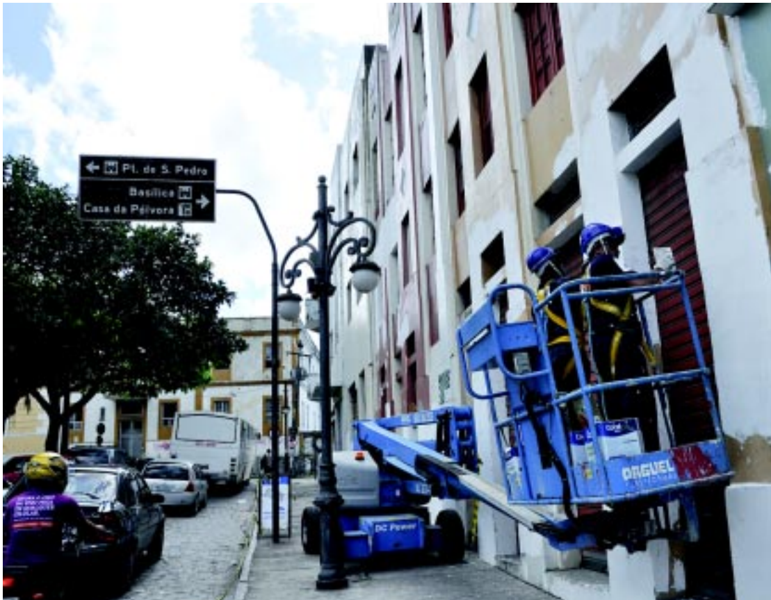
Os técnicos estão lixando as paredes, fazendo retoques e deixando toda a área limpa para receber a tinta
