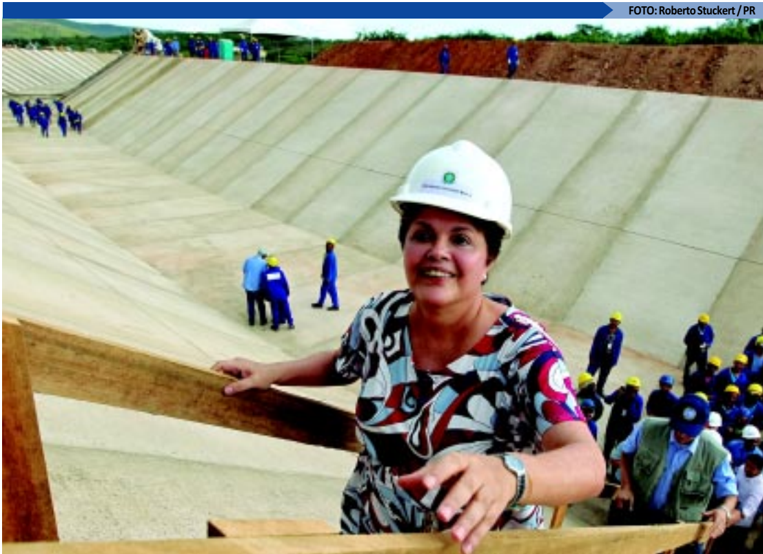
Presidente Dilma visitou, no último mês, as obras de transposição do Rio São Francisco em Pernambuco e no Ceará
