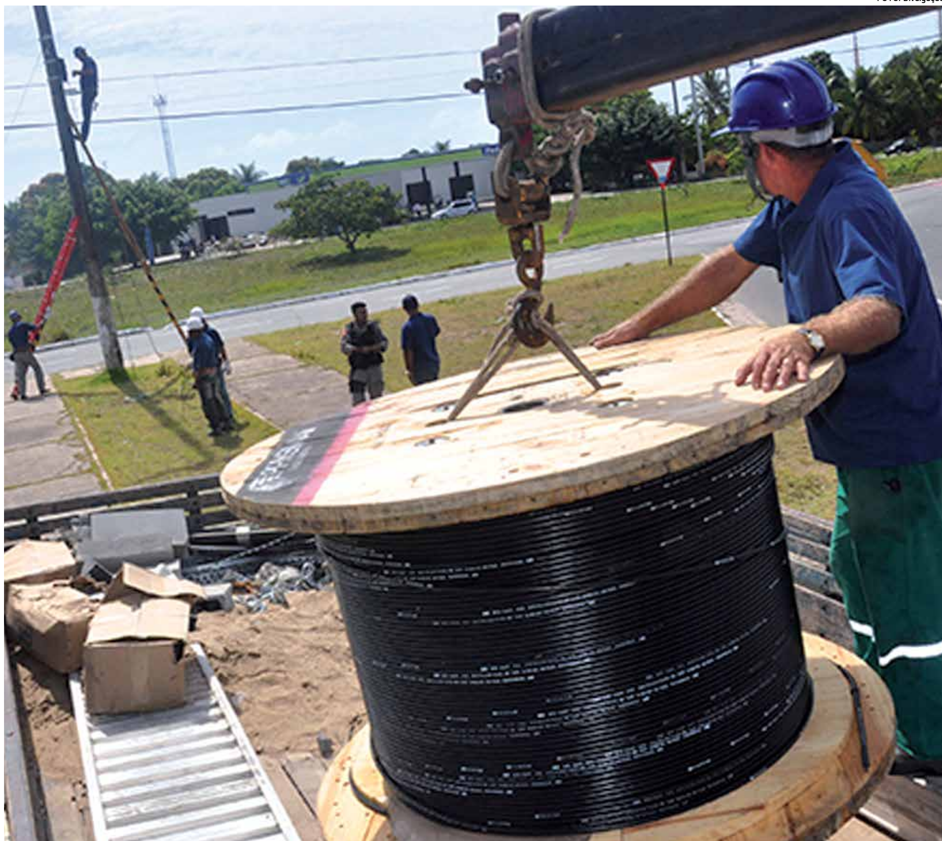
Operários implantam cabos de fibra ótica em João Pessoa que possibilitarão a instalação de uma rede que vai inserir o Estado no circuito internacional a partir de 2014
