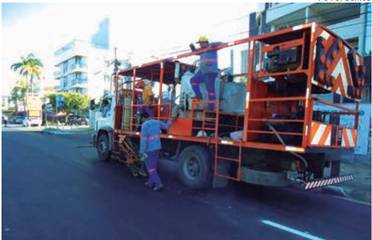
A sinalização horizontal na orla está sendo feita por etapas
