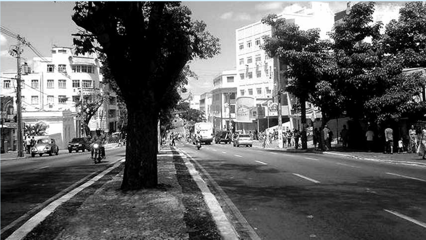
A instalação de um corredor de ônibus na Avenida Floriano Peixoto, em Campina Grande, voltou a ser motivo de discussão
