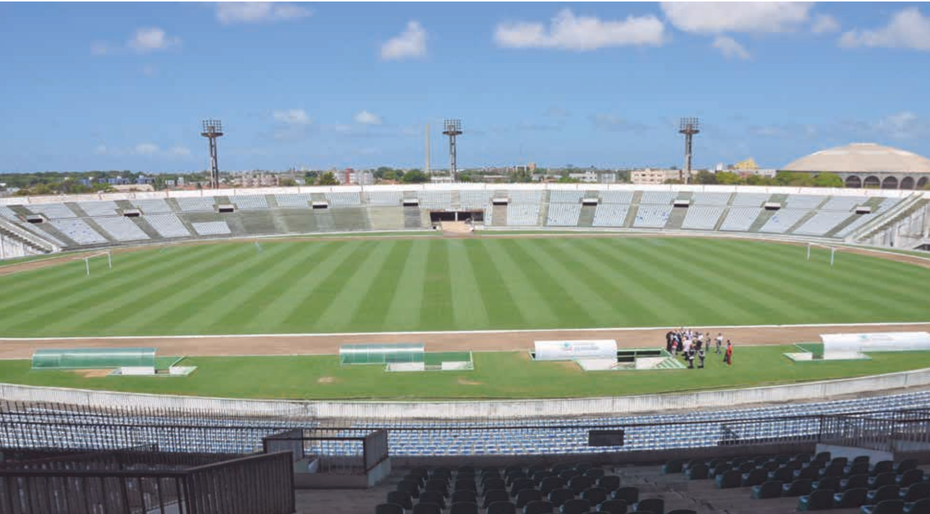
O Estádio Almeidão, que recebeu o novo gramado no padrão Fifa, está com obras estruturais adiantadas e brevemente terão início os trabalhos na parte externa
