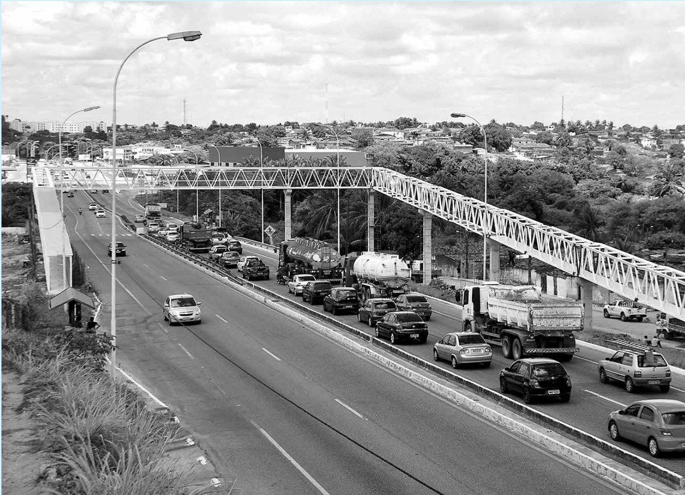
A passarela metálica tem um total de 217 metros entre o vão central e as rampas laterais, que também já foram montadas
