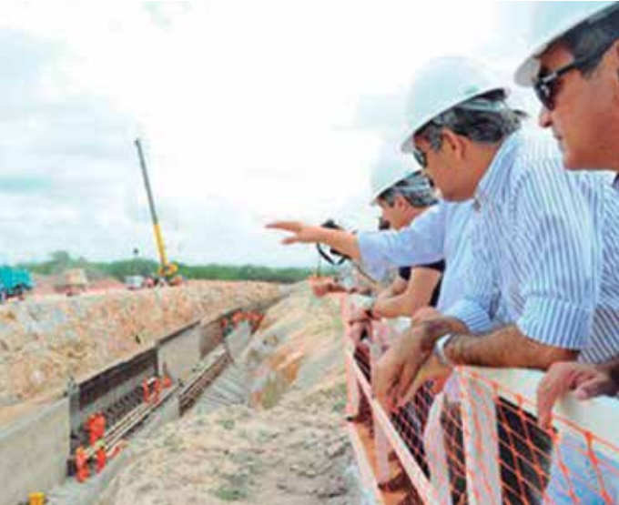
Pequenos e grandes empreendimentos espalhados pelo Estado
