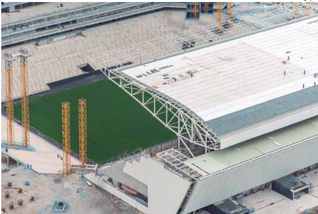
A Arena do Corinthians, que ainda está em obras, teve orçamento maior que o Ninho do Pássaro
