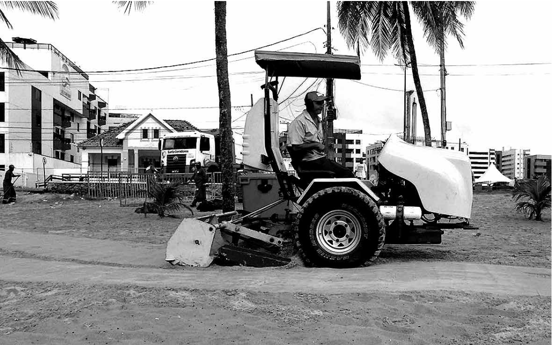
Tratores foram utilizados para fazer a limpeza da área reservada onde as tendas serão instaladas
