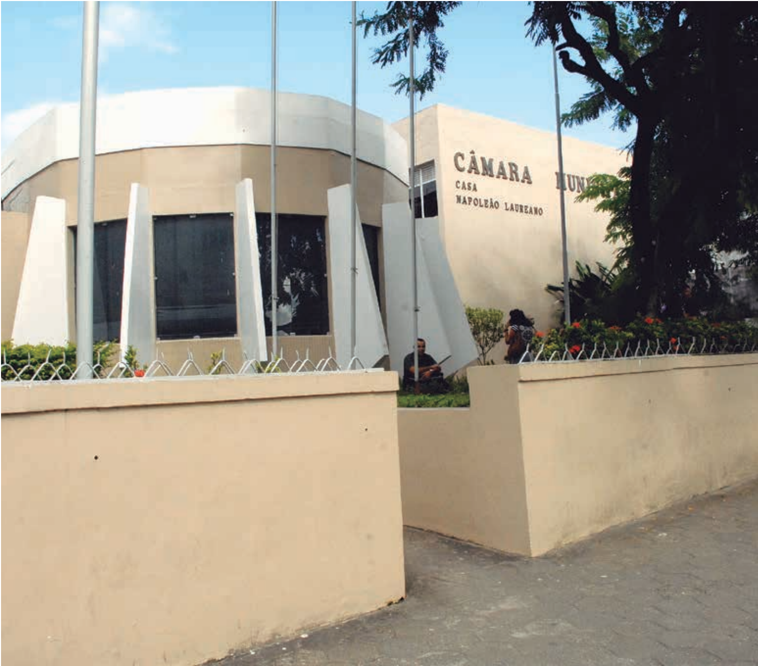
A Câmara de JP passou por atrasos na reforma e equipamentos de transmissão de TV foram danificados, prejudicando o início dos trabalhos
