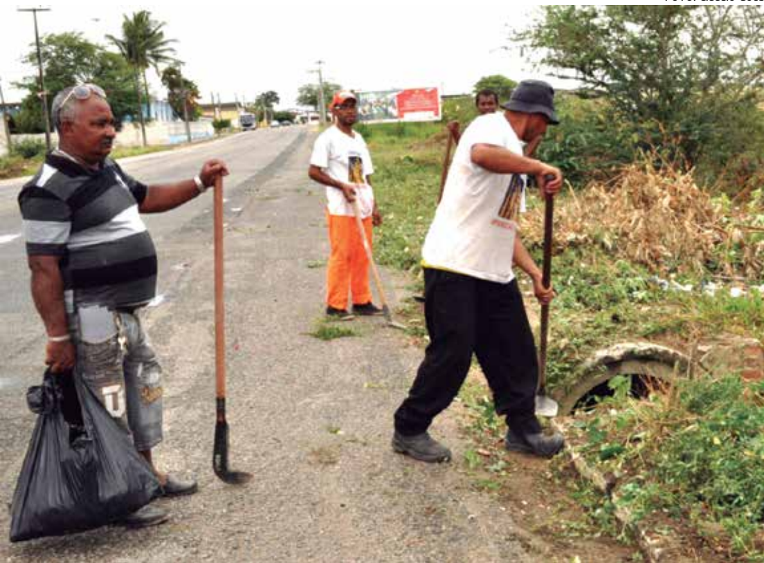
Funcionários da Prefeitura já são vistos em bairros afastados fazendo a limpeza dos bueiros
