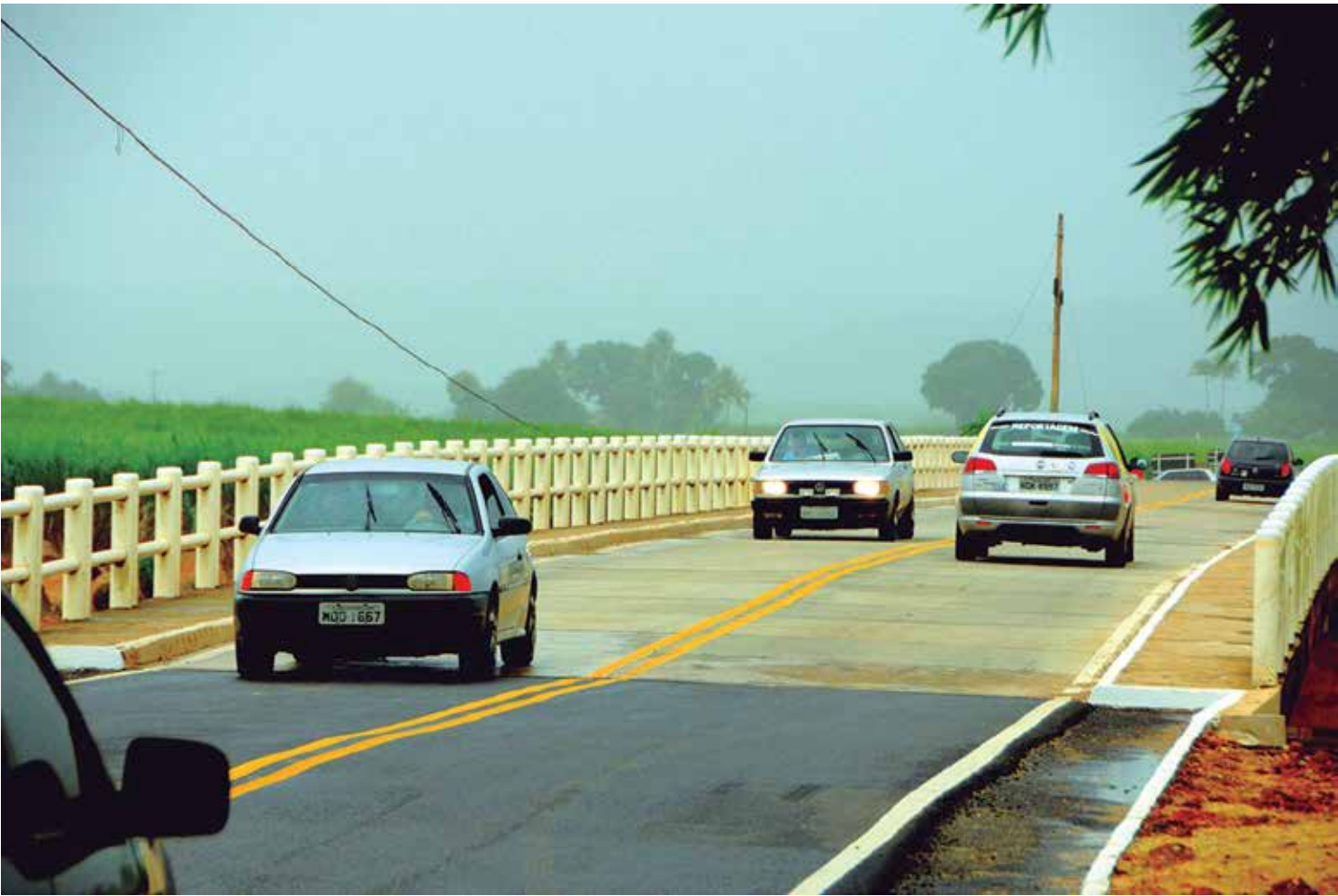
A Ponte da Batalha foi recuperada e ampliada pelo DER, após ter sido destruída em julho de 2011, durante a cheia do rio Paraíba
