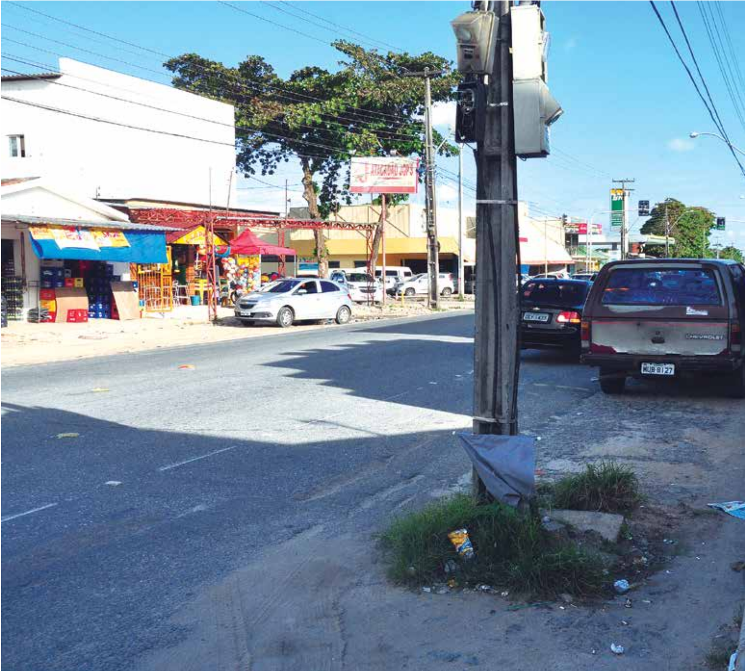
Avenida Cruz das Armas vai ganhar duas pistas de 7 metros cada, canteiro central com 1 metro e calçadas laterais com 2,5 metros
