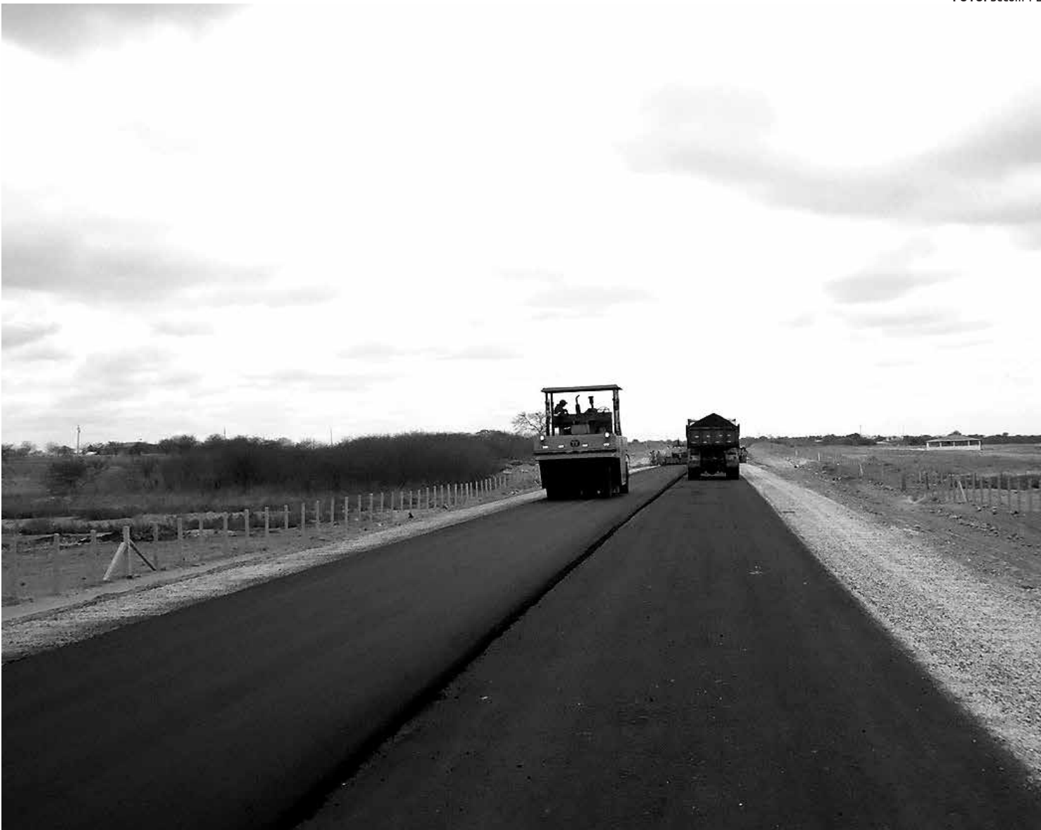
O trecho que liga as cidades de Assunção e Salgadinho já recebeu várias obras, como terraplanagem, asfalto e construção de pontes
