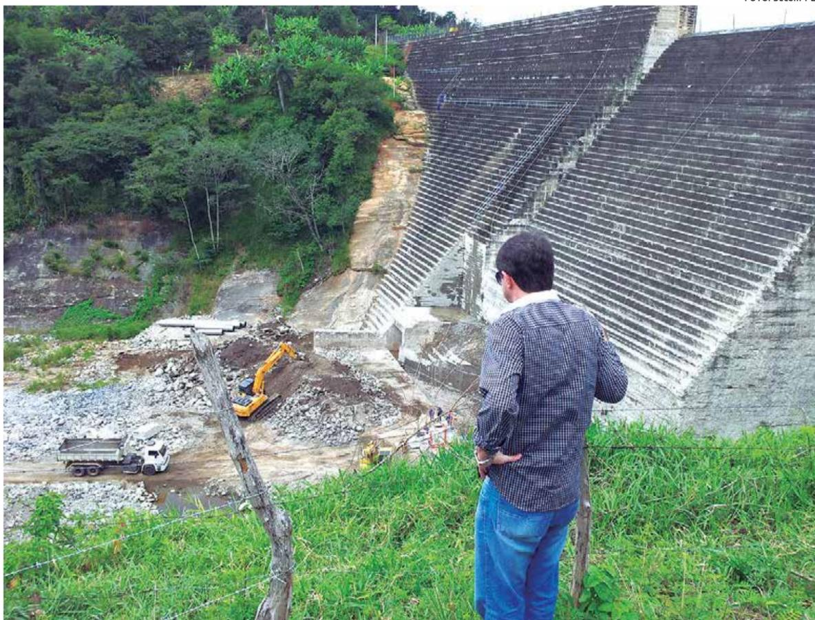
O canteiro de obras já conta com quase 100 operários, escavadeiras hidráulicas, caminhões caçamba e máquina de corte a fio
