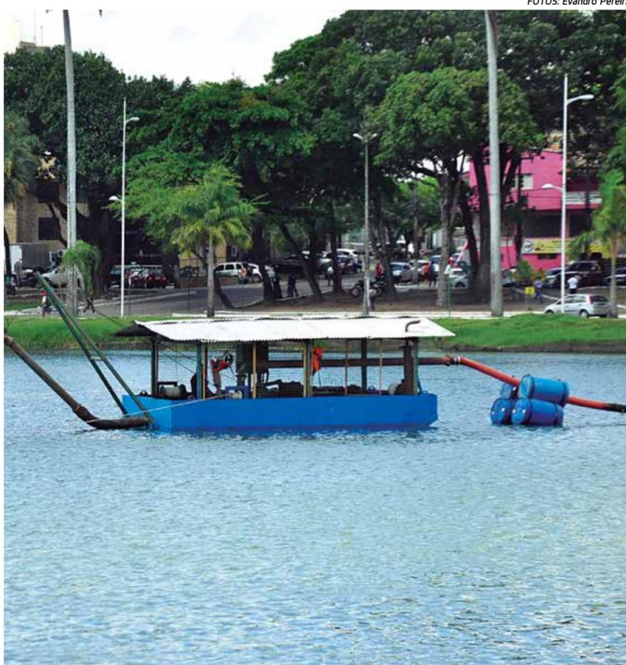
Equipamento faz a remoção de excesso de areia; excedente de água será escoado para o Rio Sanhauá
