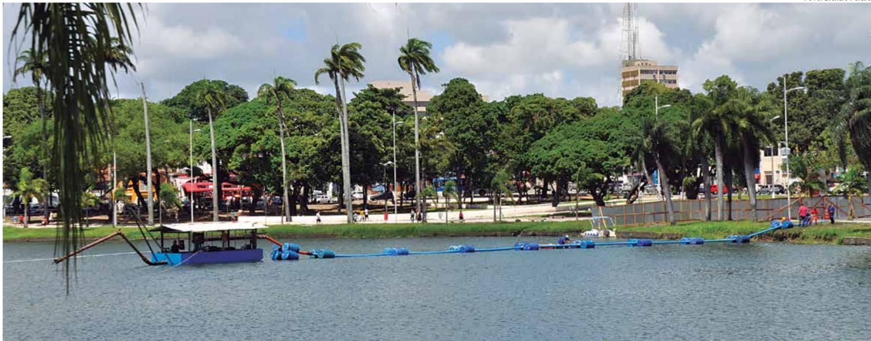
Máquinas começaram o processo de desassoreamento, com a retirada dos resíduos sólidos do fundo da Lagoa, o que deve aumentar a profundidade para até 15 metros
