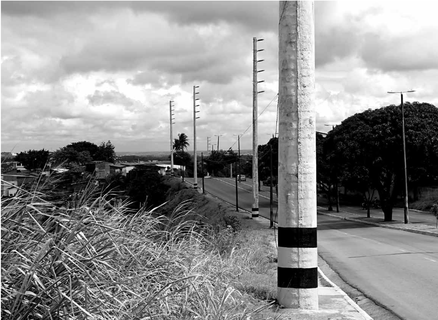
Os novos postes medem mais de 9 metros de altura, são circulares e são divididos em peças de seis metros para serem instalados
