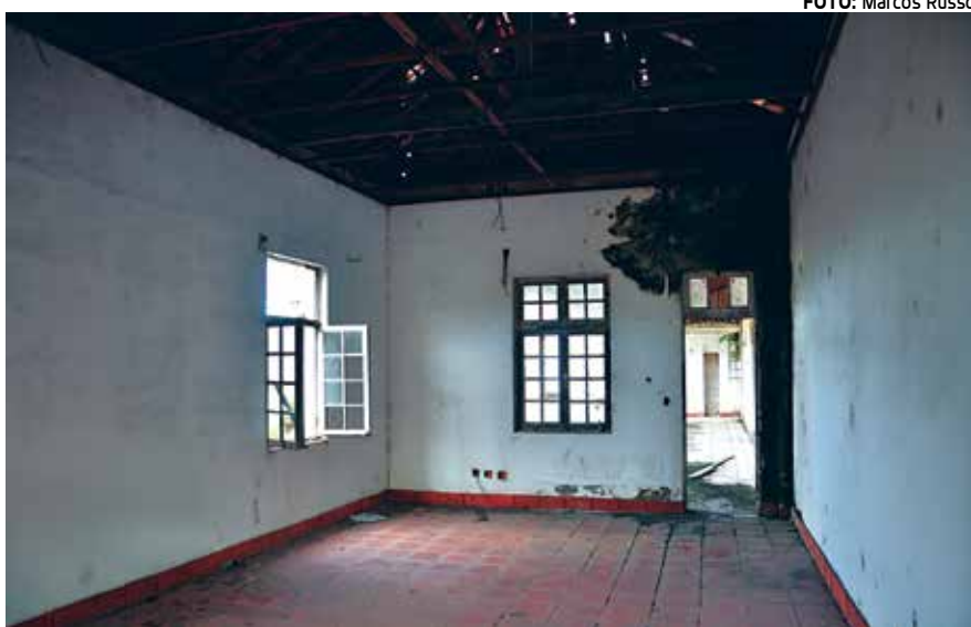
Restauração do Conventinho está à espera de lançamento de uma licitação
