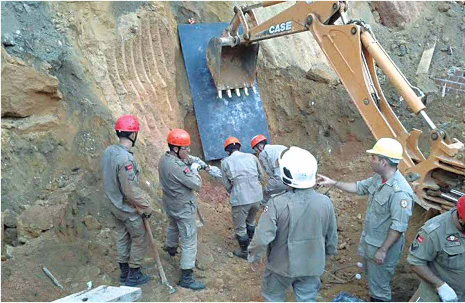
Soldados do Corpo de Bombeiros trabalham no resgate das vítimas soterradas em uma obra no bairro do Altiplano, em João Pessoa
