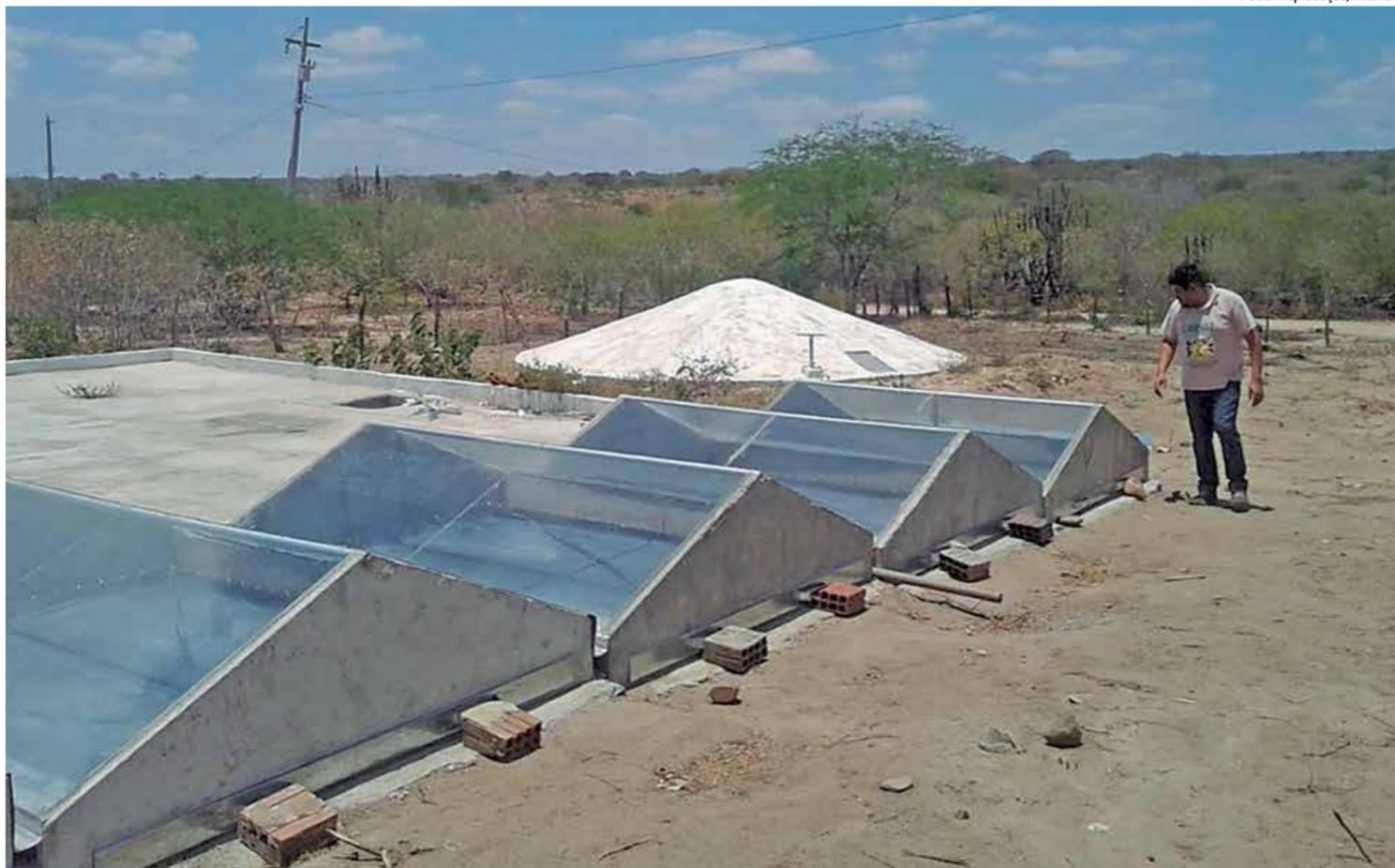
Dessalinizadores aproveitam o potencial de energia solar e fornece a produção de água potável para 29 famílias do Assentamento Olho D'água, na região do Semiárido
