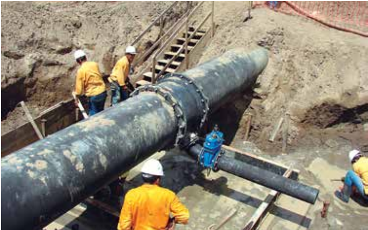
Estão em execução 42 obras; dois milhões serão beneficiados
