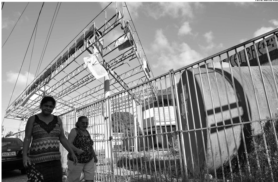
Com a desativação dos postos, os tanques, tubulações e outros reservatórios não são mais drenados, limpos e desgaseificados, podendo intensificar a contaminação
