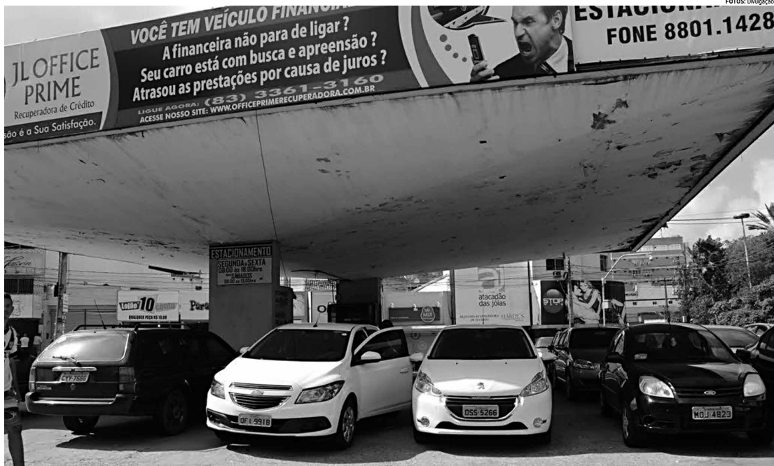
Antigo Posto Futurama, na esquina da Praça Clementino Procópio, no Centro da cidade, que foi transformado em estacionamento, foi um dos que tiveram seus tanques de combustíveis removidos
