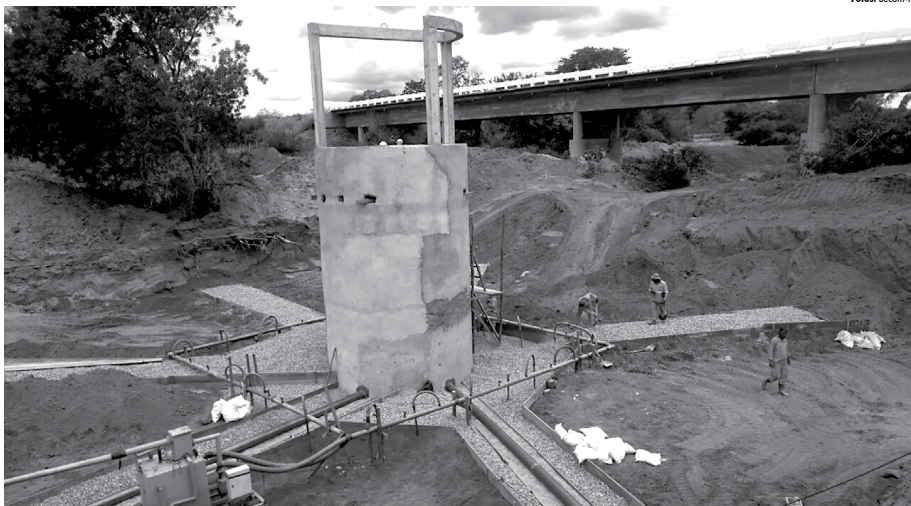
Atenção, a Cagepa deve conduzir as obras de captação d'água do São Francisco no leito do Rio Paraíba, para alimentar o sistema do Congo, que complementa o abastecimento em Monteiro
