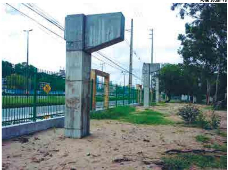
Pilares laterais já foram construídos e na terça-feira começa a construção do vão central da passarela
