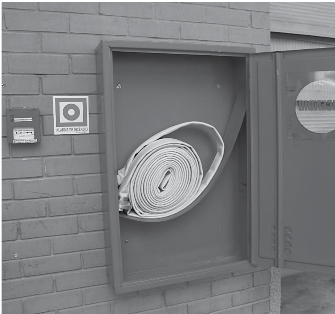
Hidrantes com mangueiras de proteção, detector de fumaça, bomba de alarme e e sirene para incêndios estão entre os novos equipamentos instalados
