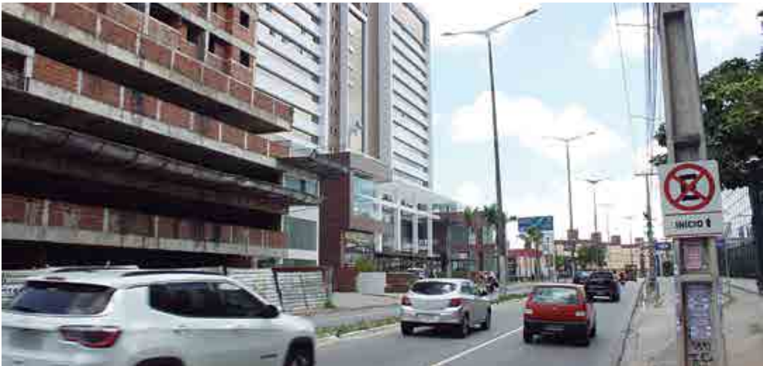
Na principal avenida dos Bancários, novos empreendimentos em construção devem aumentar o fluxo de veículos, que já é intenso no local nas horas de pico
