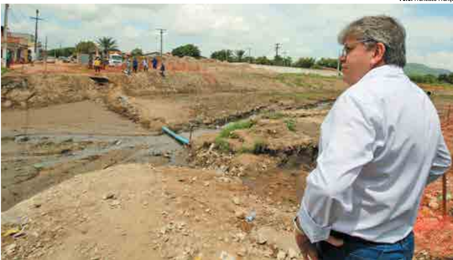
Governador João Azevêdo destacou que a ponte vai mudar e trazer qualidade de vida para a comunidade, que fica isolada, sem ter acesso a serviços e à escola
