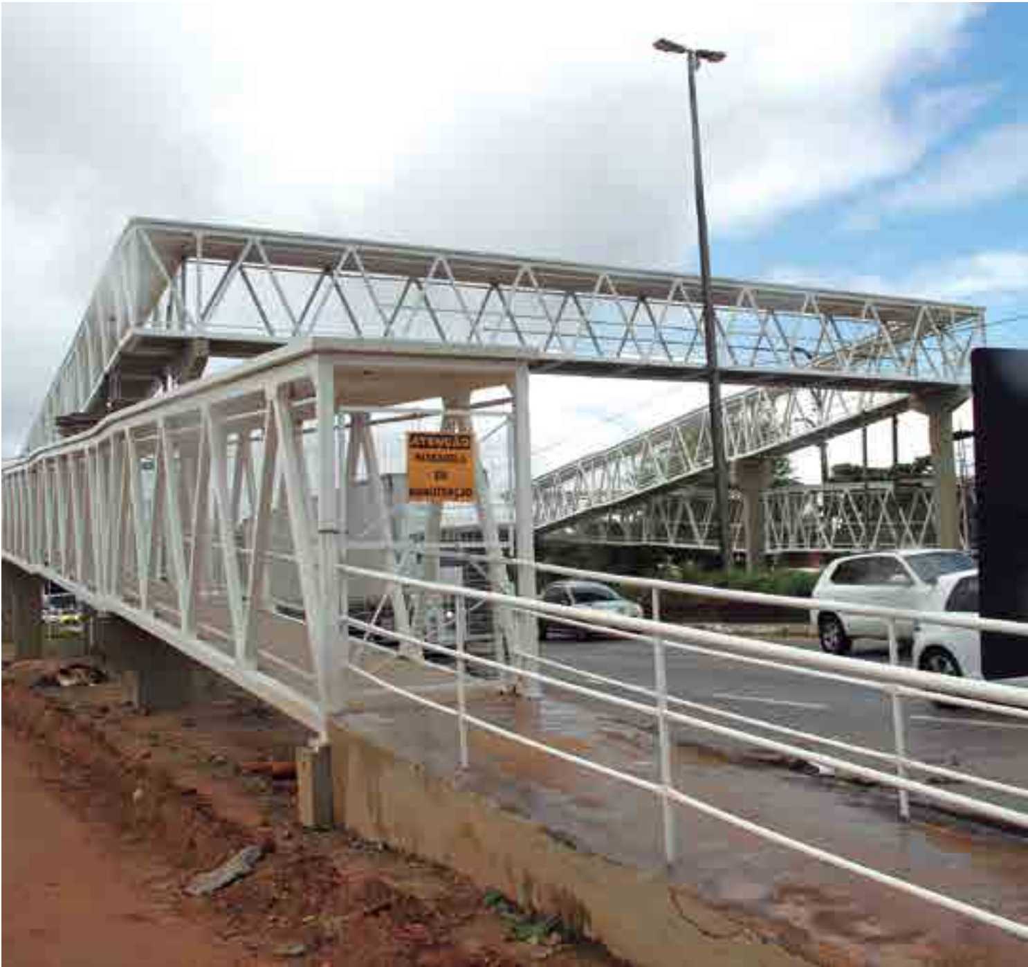
Passarela do conjunto Renascer será uma das quatro que o Governo Estadual implantou na BR-230 no trecho entre Cabedelo e o Viaduto de Oitizeiro
