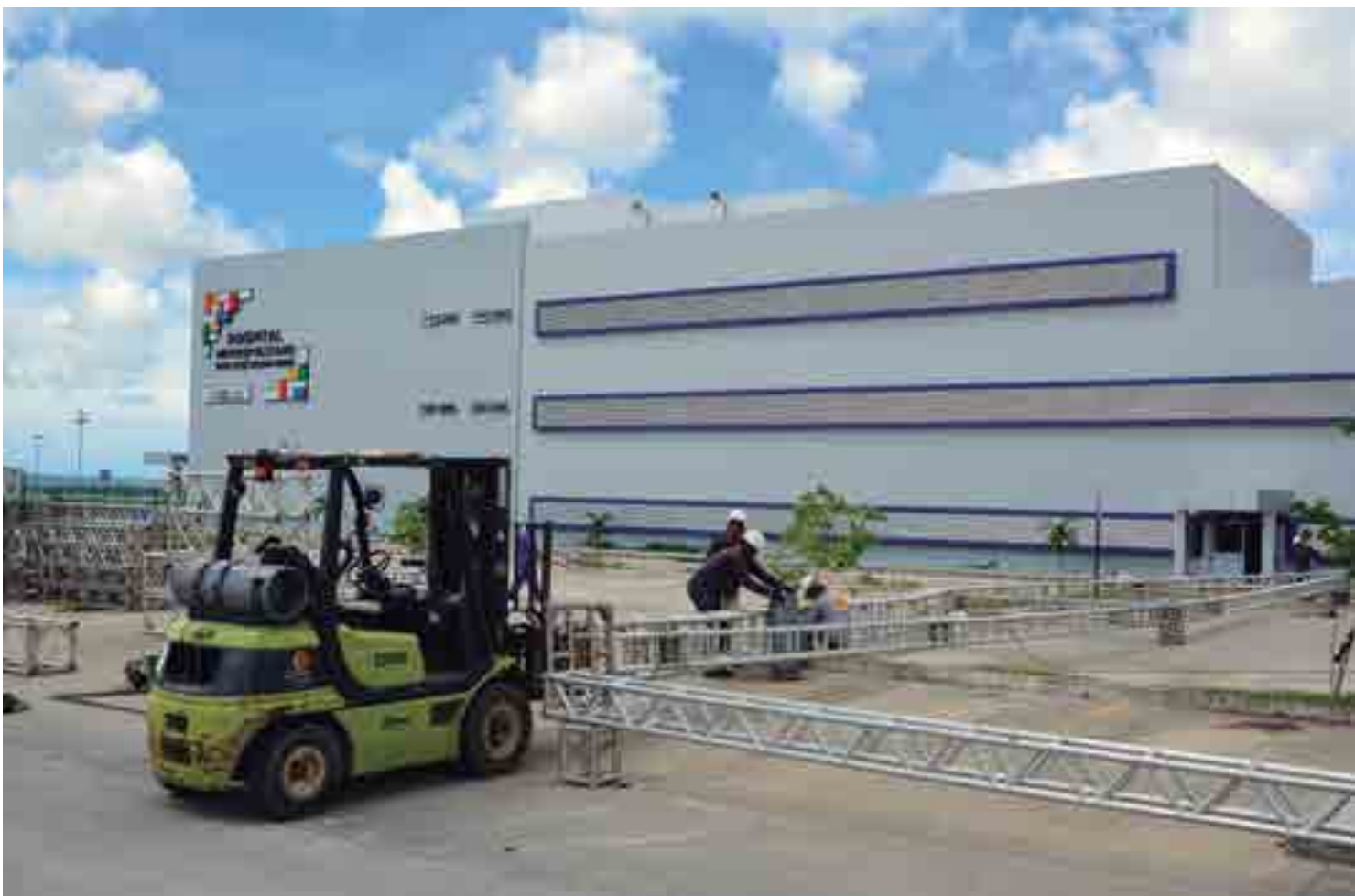
Montagem do hospital teve início ontem, no estacionamento do Metropolitano, em Santa Rita e estrutura terá área de quase 2,5 mil metros quadrados
