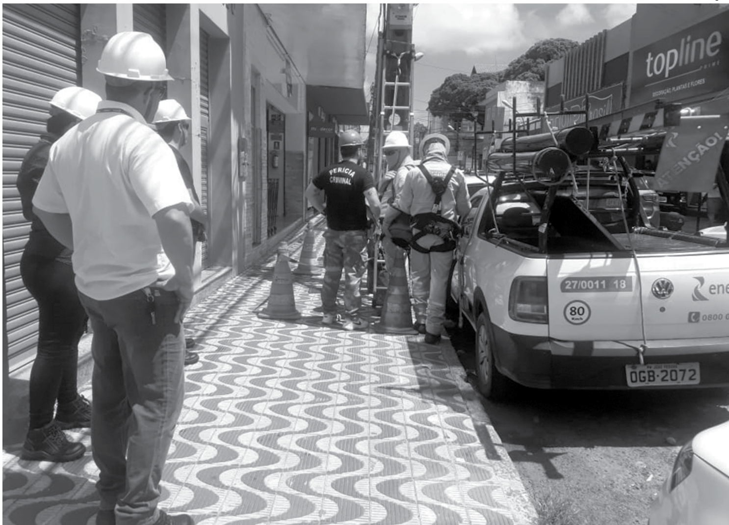
Os funcionários da Energisa, juntos com policiais civis e peritos constataram o roubo de energia em estabelecimentos comerciais no Centro de João Pessoa
