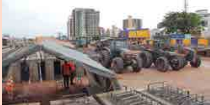
As obras realizadas neste trecho da BR-230 estavam paralisadas
