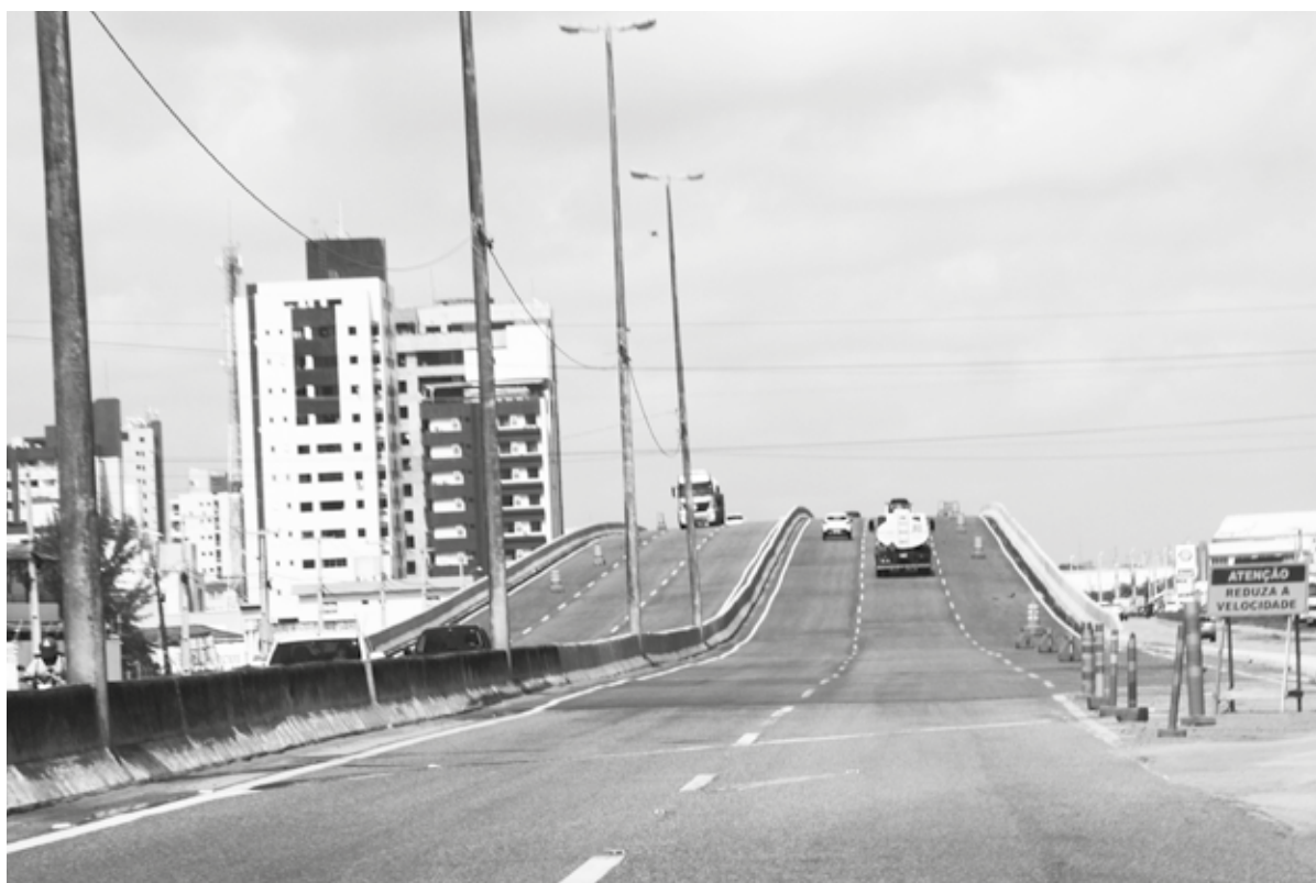
Os dois viadutos construídos dentro do projeto de ampliação da BR-230 entre João Pessoa e Cabedelo foram liberados para o trânsito há três meses.
