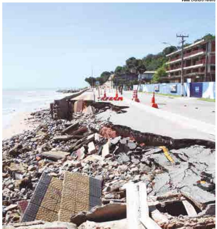
Calçada e parte da pista de rolamento tiveram trechos inteiros destruídos pela erosão causada pelo avanço do mar
