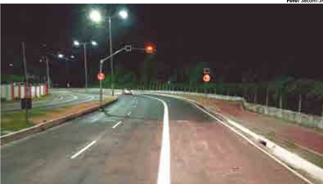
Pintura da sinalização foi a última etapa do trabalho de recuperação da avenida após o rompimento de uma tubulação pluvial
