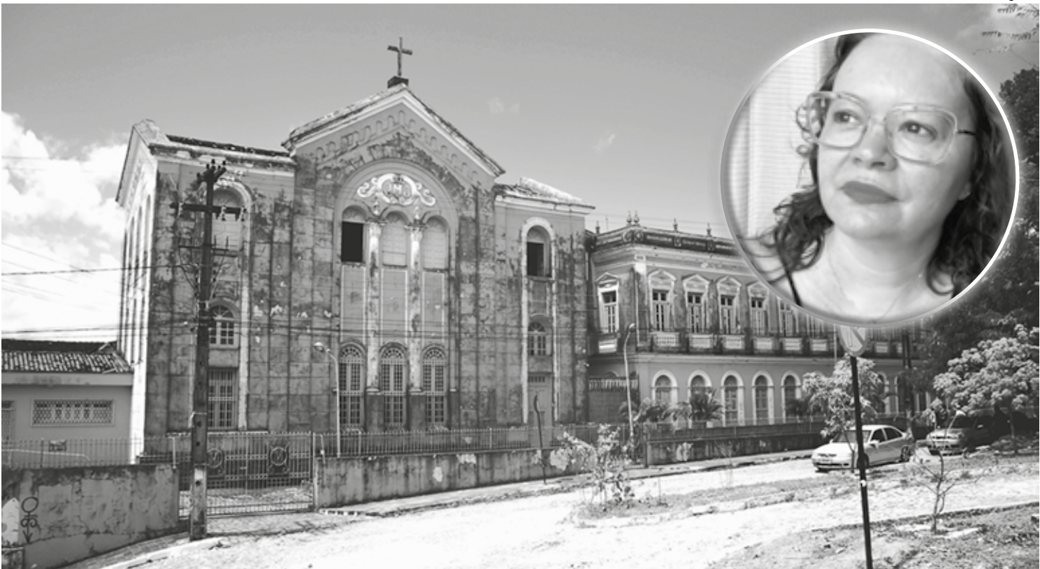
Em processo de instalação no antigo Colégio das Neves, Parque Tecnológico se propõe a ouvir propostas da comunidade, explica a coordenadora do espaço, Francilene Garcia
