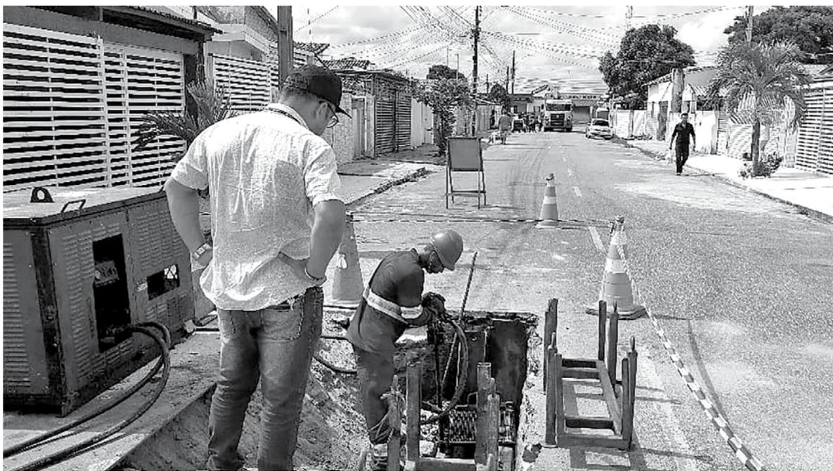
A Cagepa iniciou a substituição de um trecho de rede de distribuição de água pelo Método Não Destrutivo, em João Pessoa
