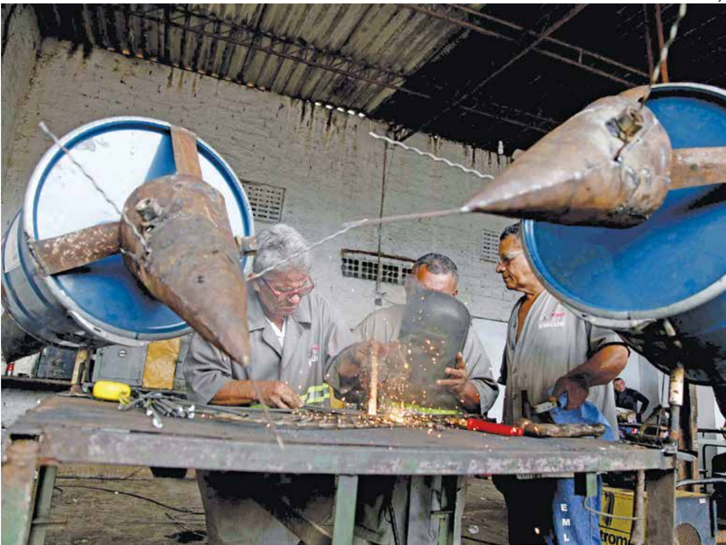
Muriçocas gigantes que irão decorar a concentração do bloco, em Miramar, foram construídas com vigas de ferro, tambores e chapas de ferro
