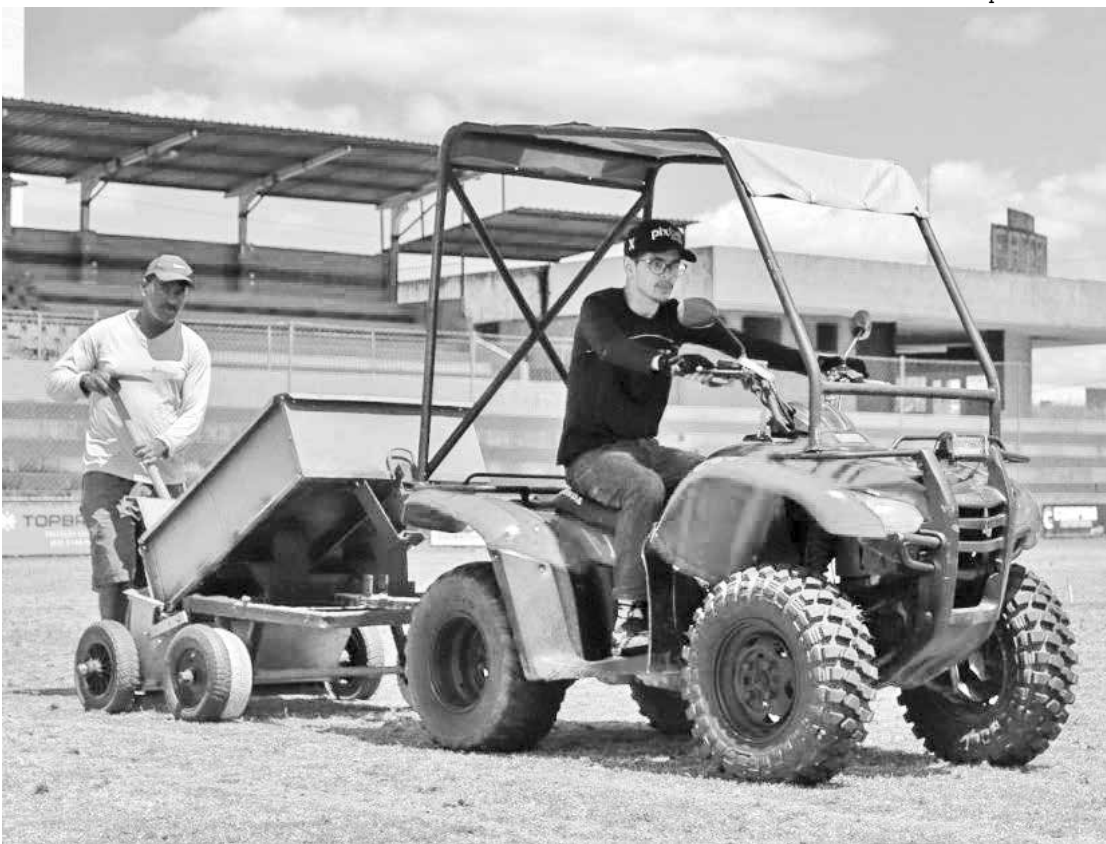
As obras no Renatão estão em ritmo acelerado, com o gramado sendo totalmente reformado
